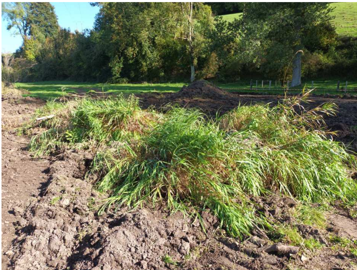
Image 47 : mise en jauge des hélophytes pour un usage ultérieur sur le chantier.
