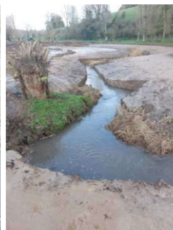
Images 74 à 76 : les nouvelles formes du cours d'eau commencent à s'affiner. Les structures d'habitats déposés en berges préalablement prennent vie au sein de la nouvelle rivière.
