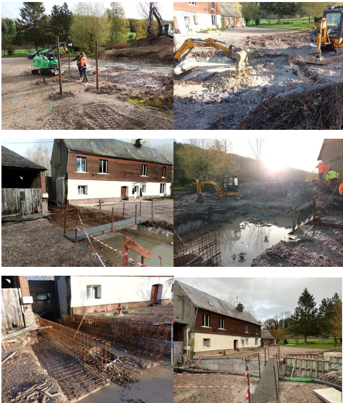
Images 62 à 67 : démolition et reconstruction du coursier du canal pour permettre à une roue d'apparat de tourner prochainement.
