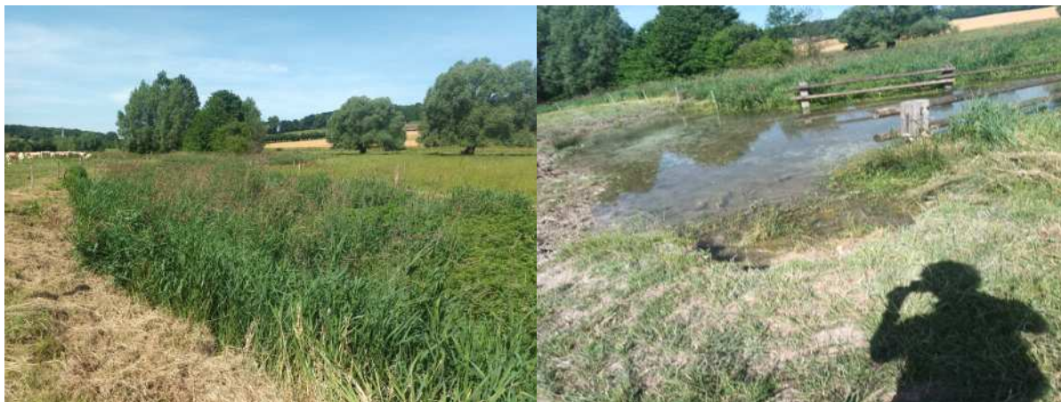
Images 97 à 99 : la surlargeur a été revue, le gué ne jouait plus son rôle – avant travaux.
