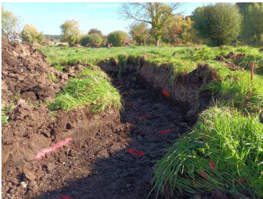
Image 46 : marquage technique pour former berges et fonds.
