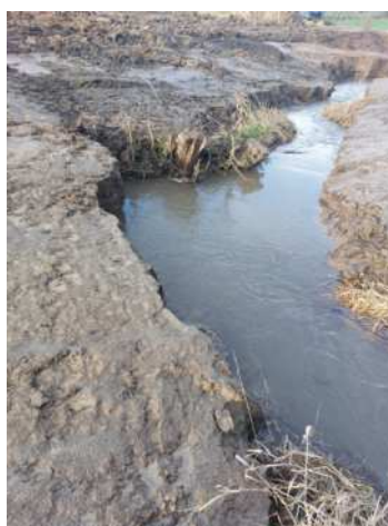
Images 74 à 76 : les nouvelles formes du cours d'eau commencent à s'affiner. Les structures d'habitats déposés en berges préalablement prennent vie au sein de la nouvelle rivière.
