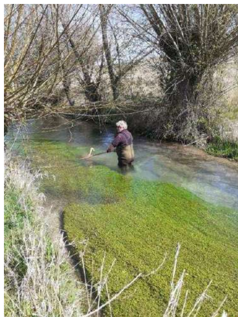
Image 5 : la technicienne de l'ASA recréant un chenal pour éviter les débordements, avant travaux.
