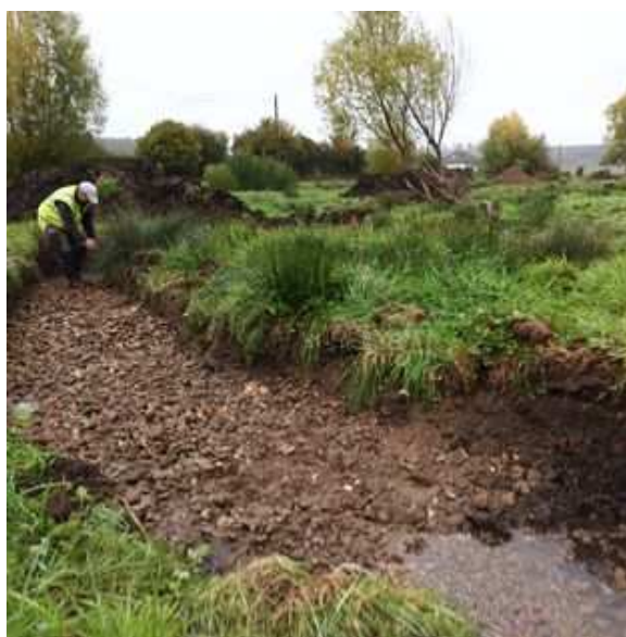
Image 48 : apports de matériaux minéraux pour préparer les faciès.
