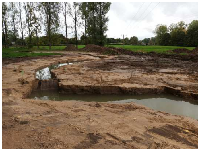
Images 42 à 44 : terrassements en cours.
