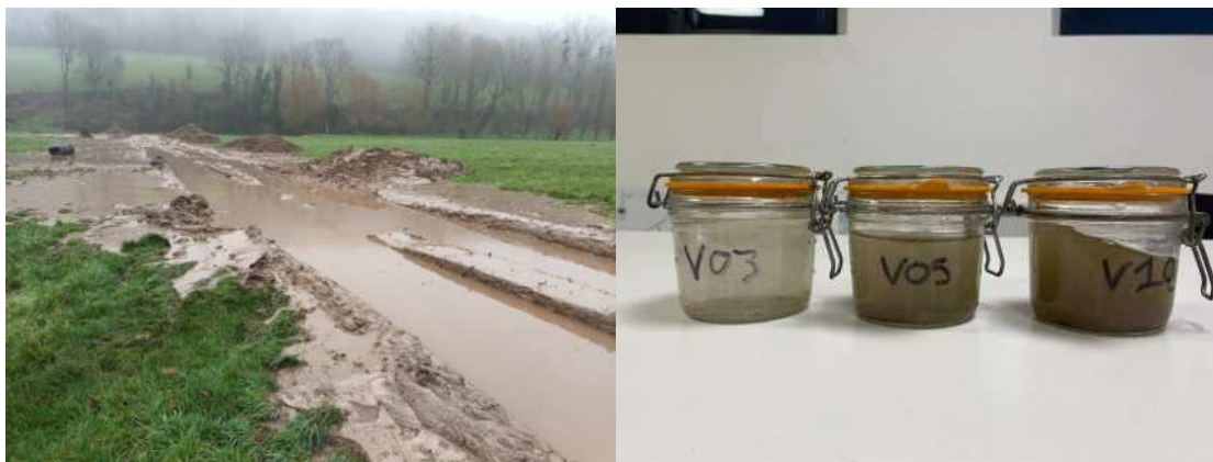
Images 87 à 88 : la pluie a ralenti les travaux et généré des relargages de matières en suspension qu'il a fallu gérer.
