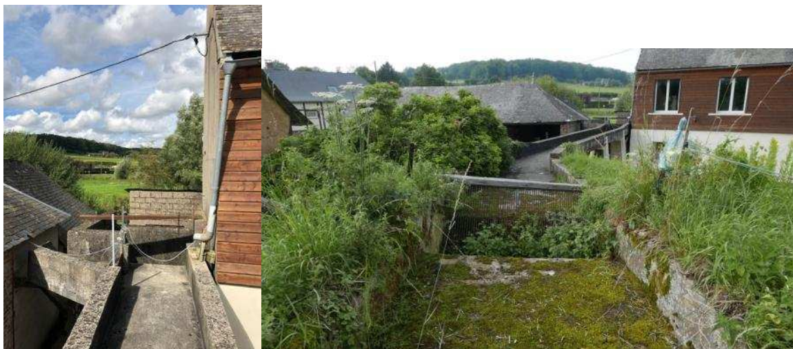
Images 9 et 10 : le bief d'amenée sur le moulin, en surplomb, avant travaux.
