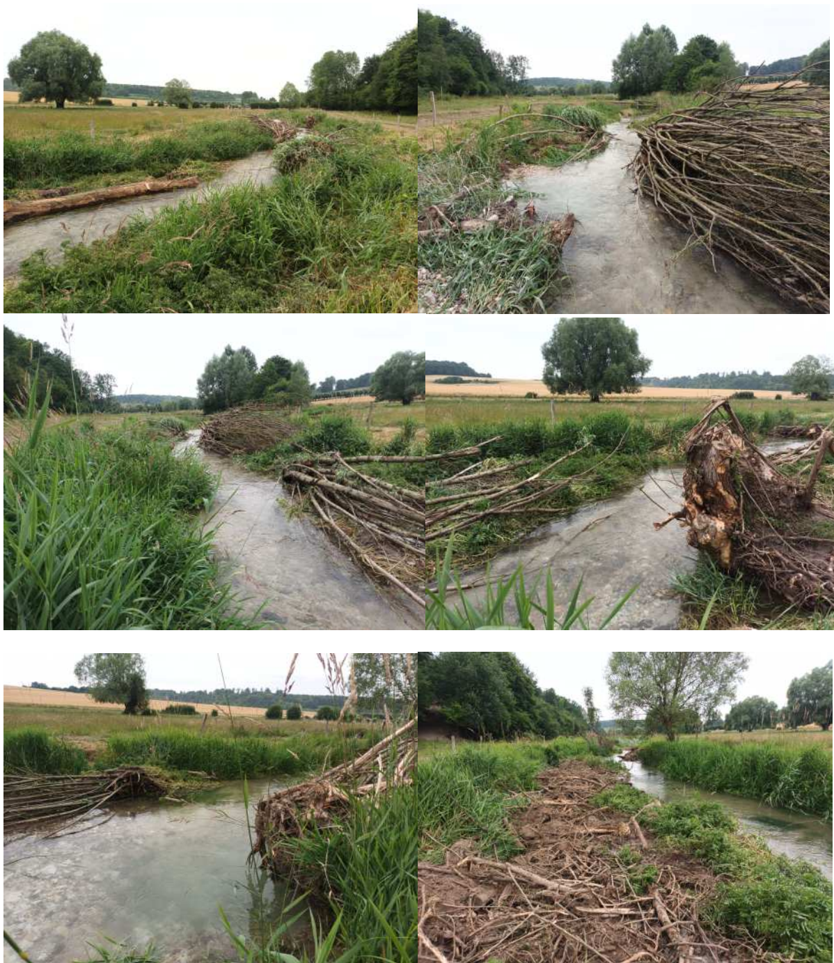
Images 100 à 105 : la surlargeur corrigée grâce aux techniques végétales – après travaux.
