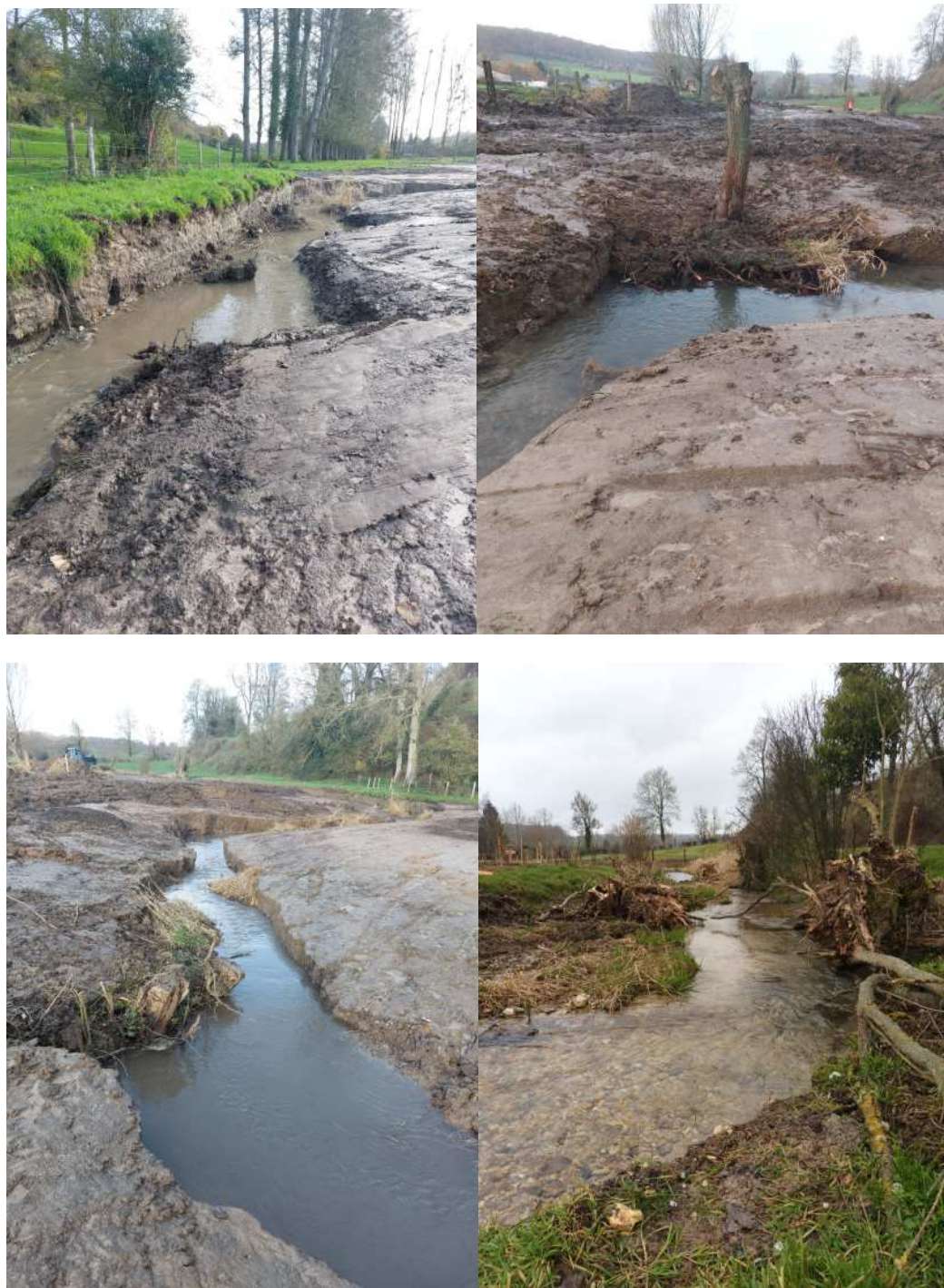
Images 77 à 80 : les structures végétales sont mises en valeur et utiliser pour favoriser l'aspect naturel, la biodiversité du projet.
