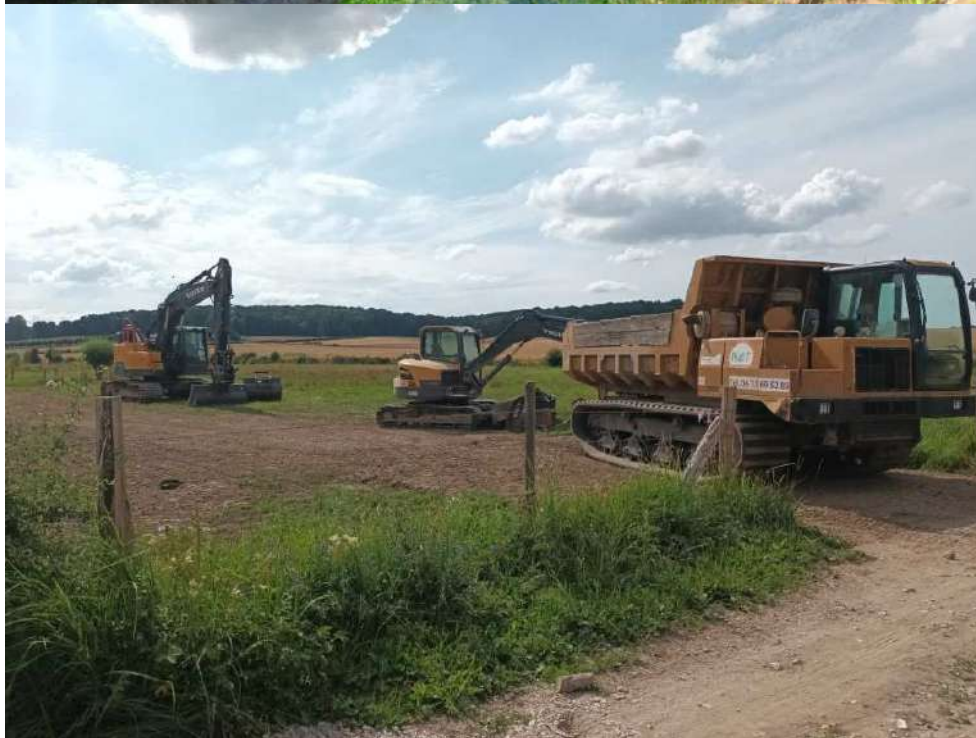
Images 110 et 111 : c'est la fin de cet imposant chantier, les engins se retirent ...
