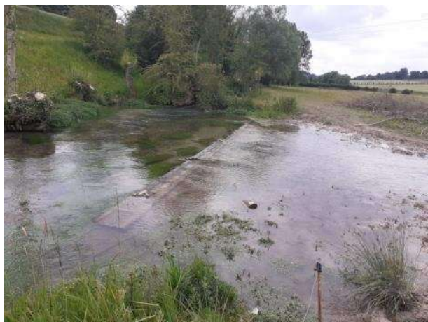
Image 6 : bief qui surversait à cause d'une rupture dans la berges du canal d'amenée au moulin, avant travaux.
